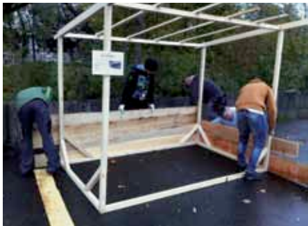
Bau Unterstand in der Hardau
